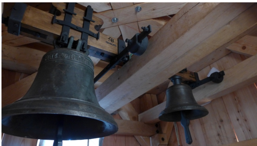
Nově vyčištěné a usazené zvony
