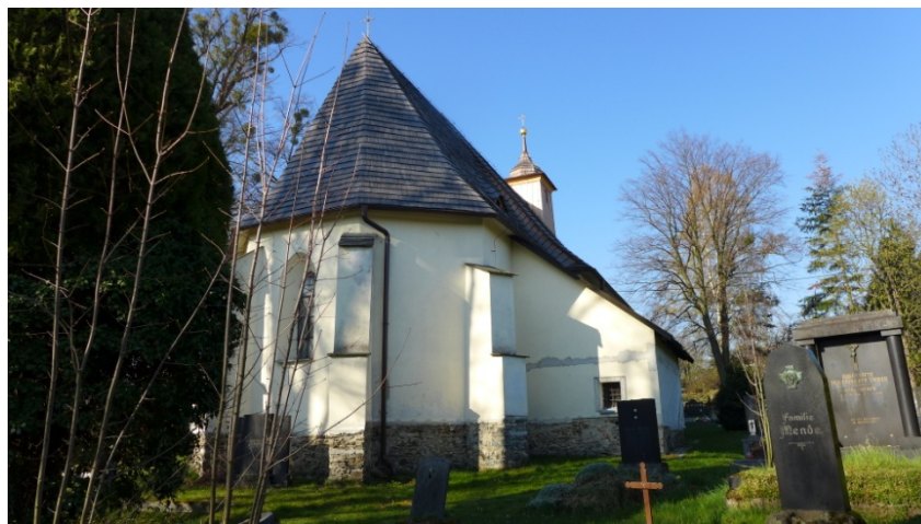
Dokončená obnova krovu a střechy
